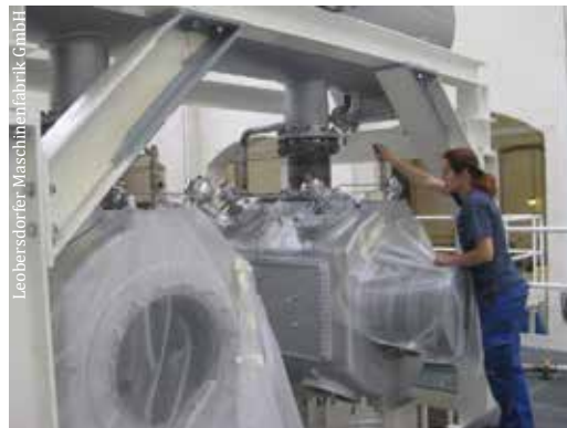
Montage einer Anlage
