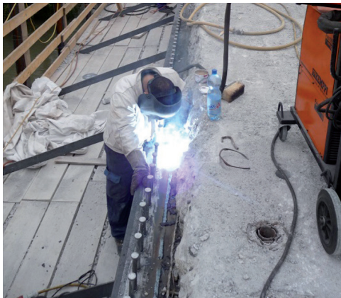
MAG-Schweißen auf der Baustelle
